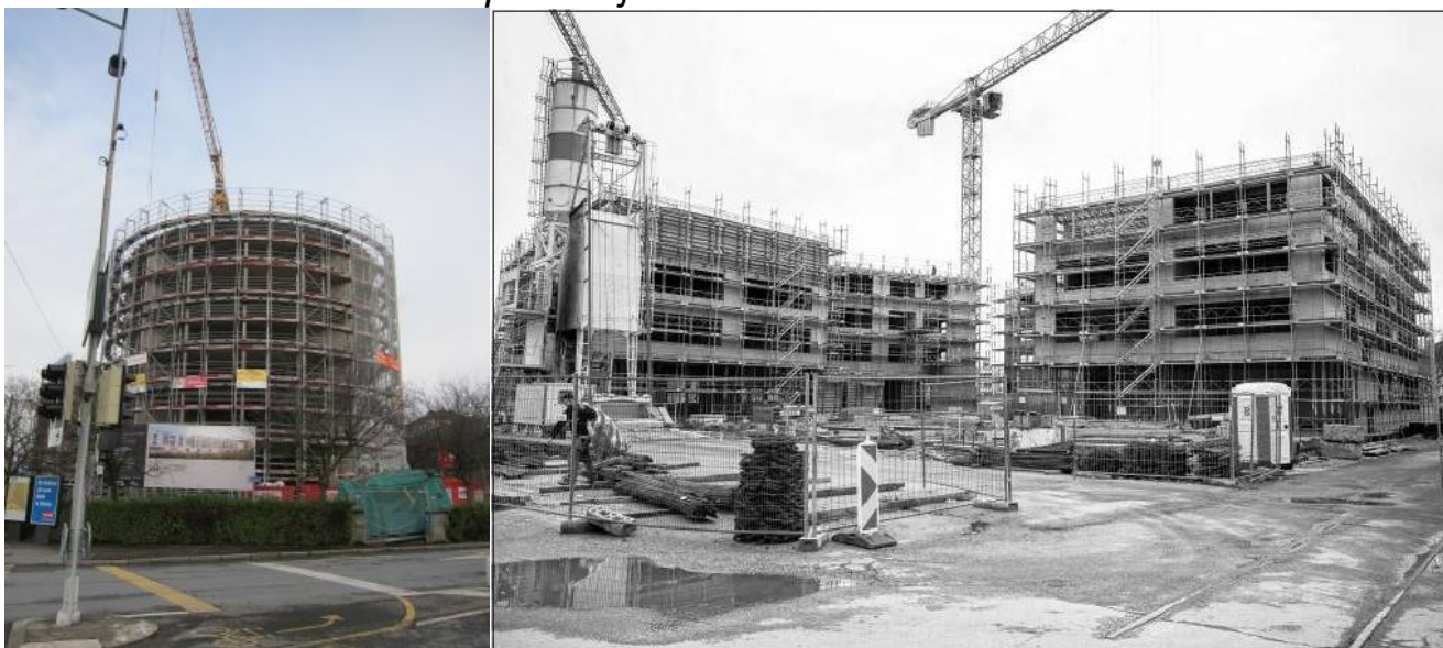
La Croisée et Le gymnase de l'Ouest lausannois (CEOL) ouvrira ses classes à la rentrée prochaine. JEAN-BERNARD SIEBER
